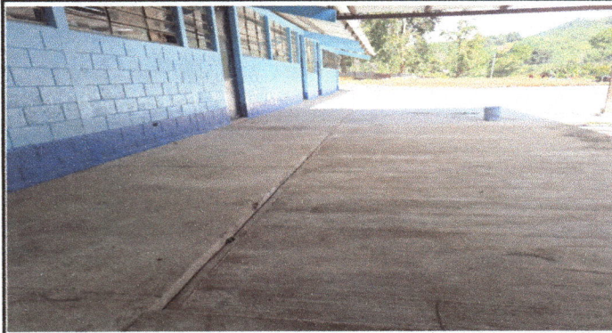
Foto 8: Torta del corredor (losa de patio) sustituida.
