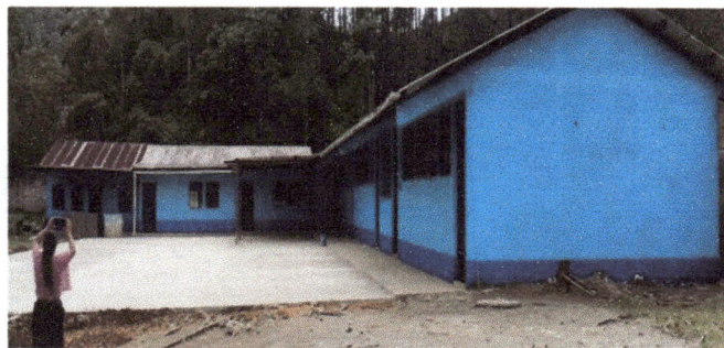
Foto 5: Paredes exteriores del módulo 1 y 2 con pintura nueva aplicada.
