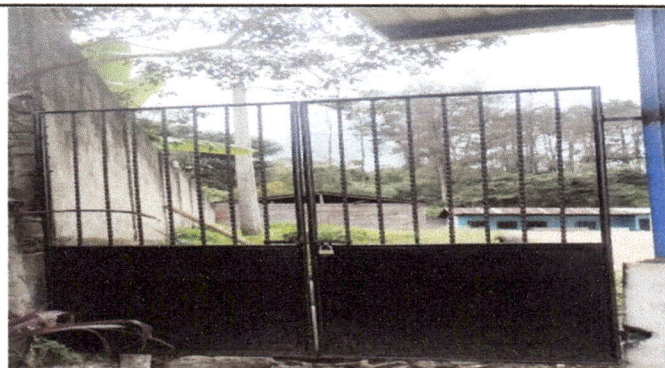
Foto 3: Portón de ingreso principal sustituido.
