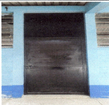
Foto 1: Puertas del módulo 1 con mantenimiento preventivo realizado.
