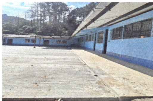
Foto 6: Torta de concreto del corredor (losa de patio) rehabilitada.
