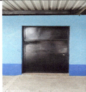
Foto 2: Puertas del módulo 2 con mantenimiento preventivo realizado.
