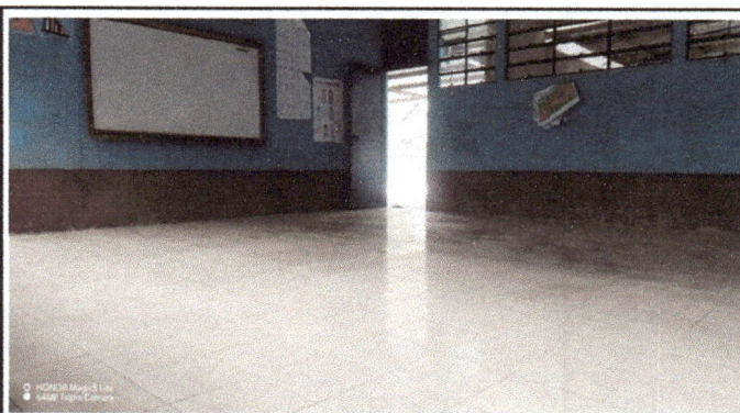
Foto 4: Piso cerámico instalado (aula No. 4 del módulo)
